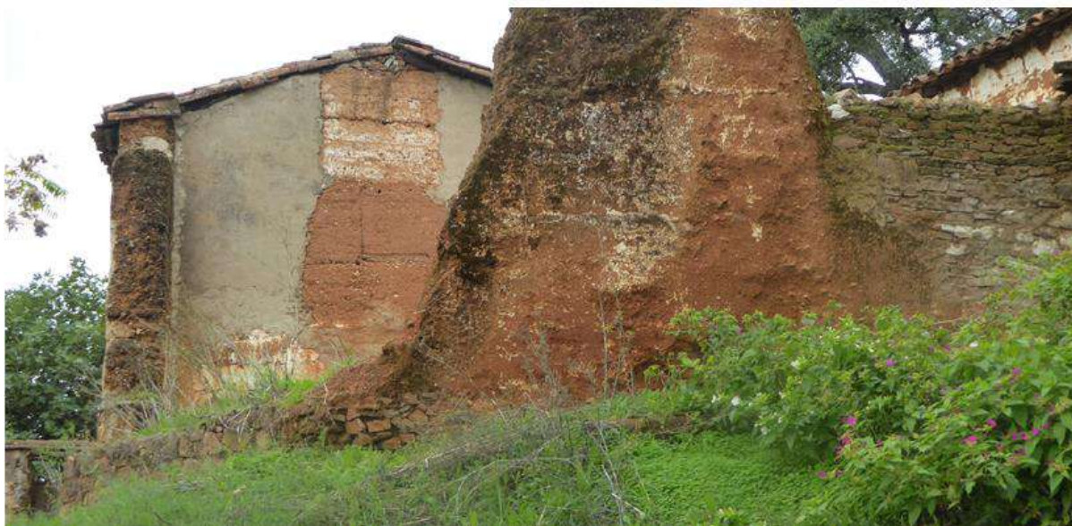
Figura 3. Morteros de cemento en los trabajos de reparación de tapias en el municipio de Alájar (Huelva, España)
