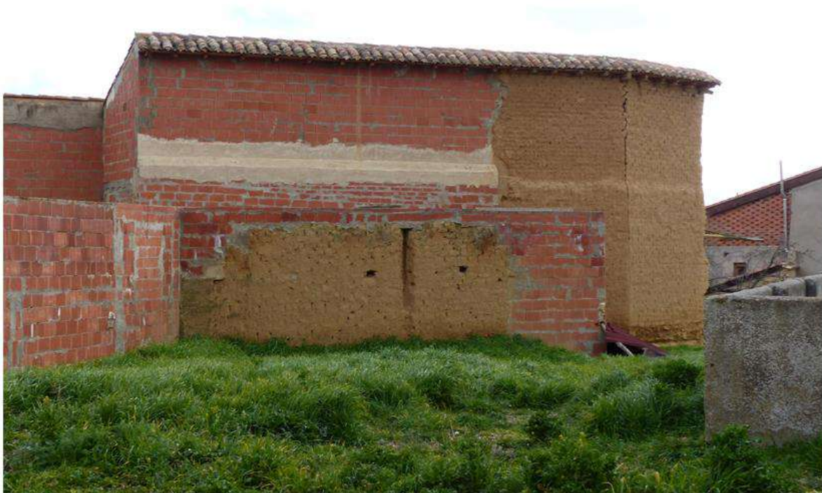
Figura 2. Casos de estudio con reconstrucciones de ladrillo y morteros de cemento en el municipio de Grajal de Campos (León, España)
